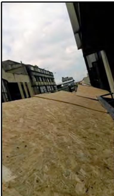
Se aprovechó la presencia de los balcones para instalar las varas corredor en diagonal soportadas sobre el balcón y haciéndoles palanca un elemento vertical adosado de techo a piso, que generara que el elemento diagonal quedara en cantiliver por fuera de la fachada y de esta manera poder sostener un tablero aglomerado que recogiera cualquier elemento que se desprendiera de la fachada y no dejarlo llegar al piso en donde circulan peatones y vehículos.
