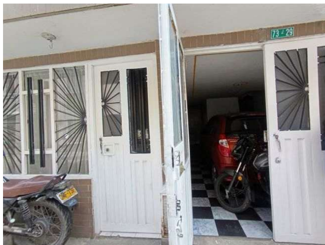
Acceso 1er piso - Apto 1
