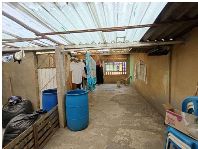
Terraza cubierta 4to piso
