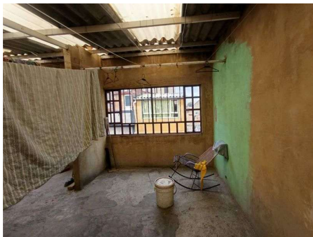
Terraza cubierta 4to piso
