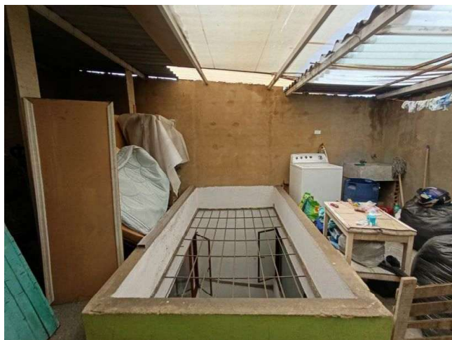
Terraza cubierta 4to piso
