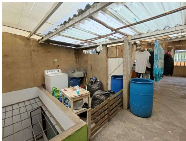
Terraza cubierta 4to piso
