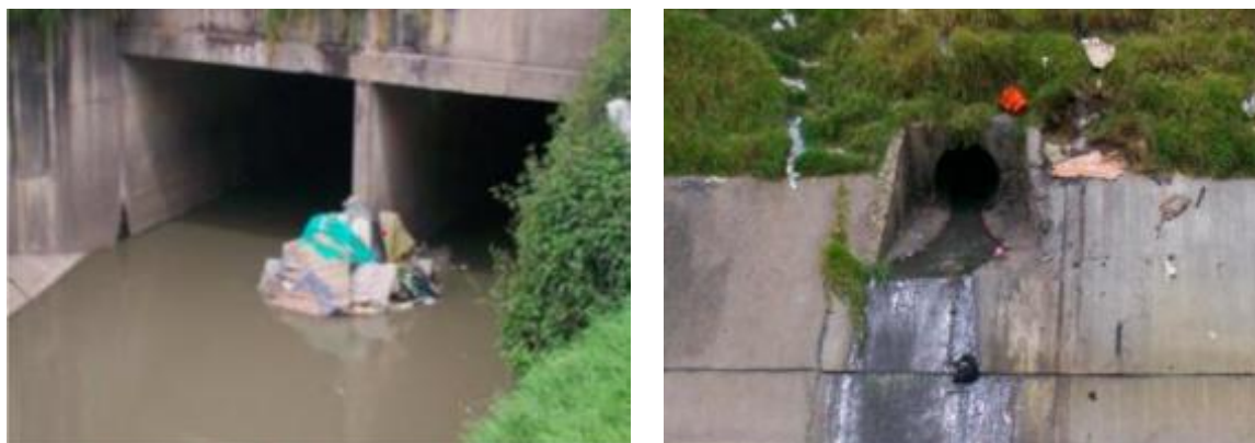
Figura 29. (a) Acumulación de sedimentos y (b) vertimiento de agua residual en el Canal Comuneros
